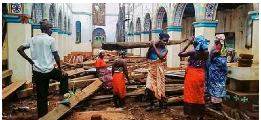
Wiederaufbau der Pfarrkirche St. Josef in Mitúcue.
